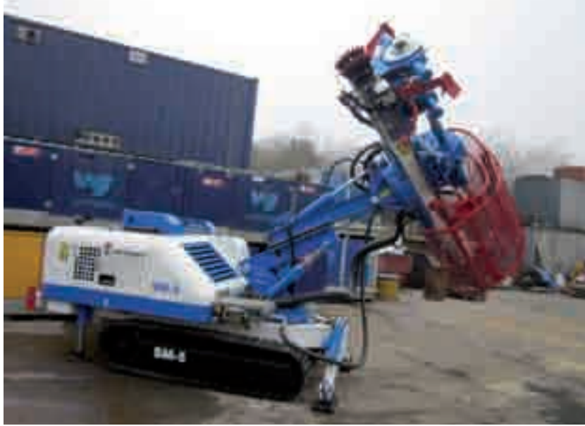
Soilmec SM-5 drilling rig.
